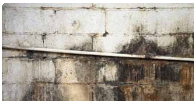
■ Umidità e microrganismi sopra il supporto
