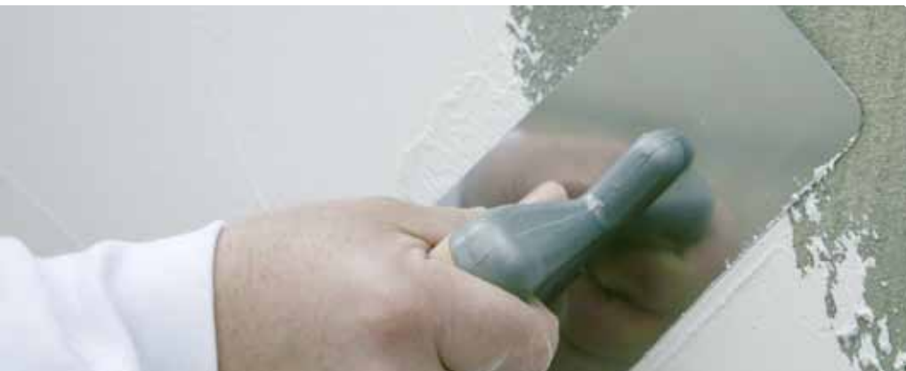
Applicazione a frattone sopra un fondo di cemento grezzo. (senza applicazione di pittura)
