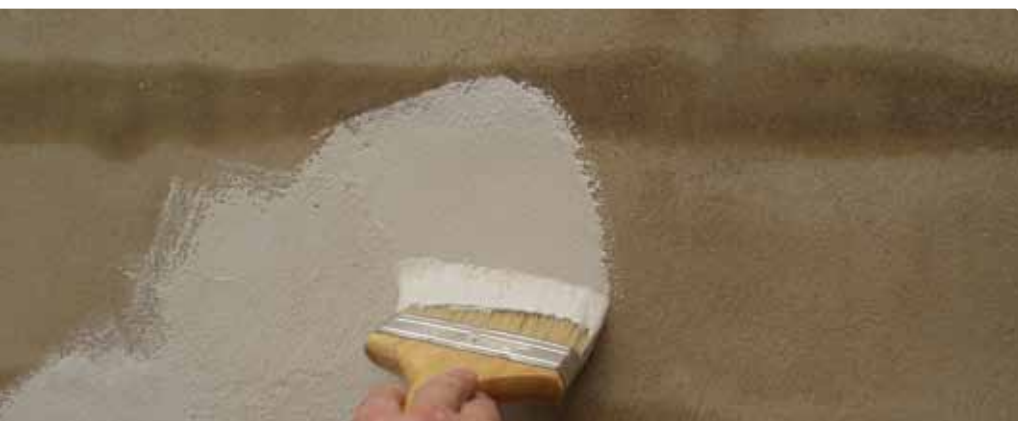
Applicazione a pennello sopra un fondo di cemento grezzo (senza applicazione di pittura)
