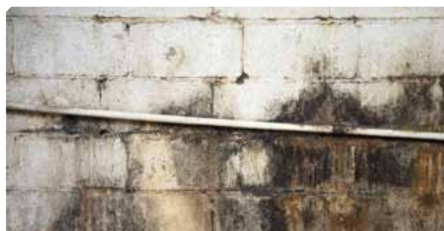
■ Umidità e microrganismi sopra il supporto
