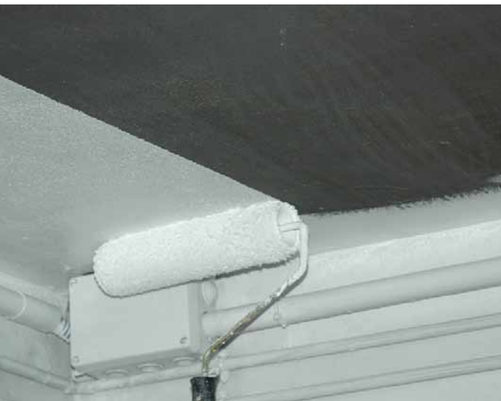
Applicazione del RX-403 sopra un supporto macchiato con fumo
